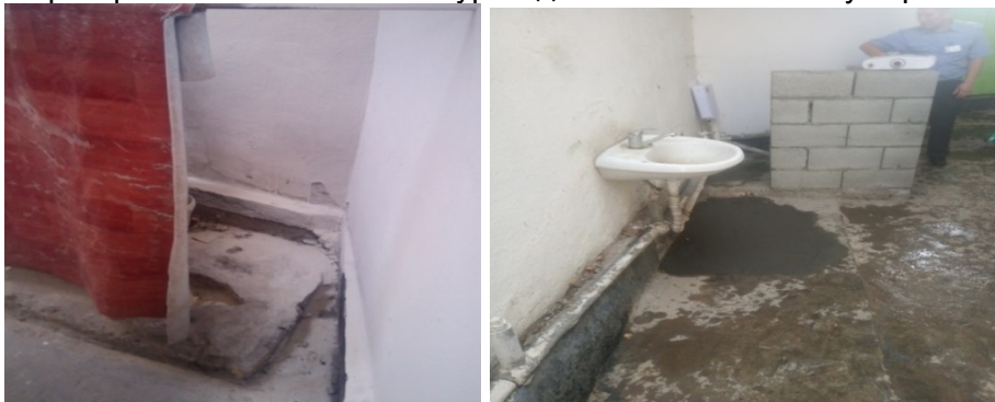
Сүрөт 89, 90: Араван районундагы ИИБ УКЖ ажатканасы ремонтко чейин жана ремонттон кийин
