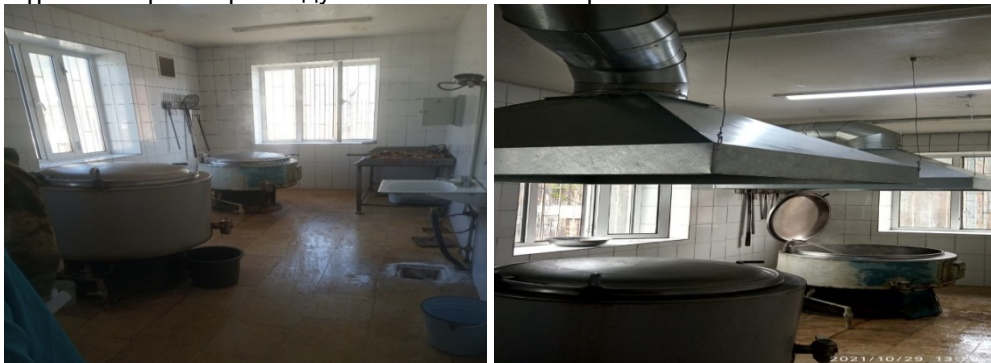
Сүрөт 92, 93: Араван райондук ИИБ УКЖнын ашканасынын ремонтко чейинки жана ремонттон кийинки абалы
