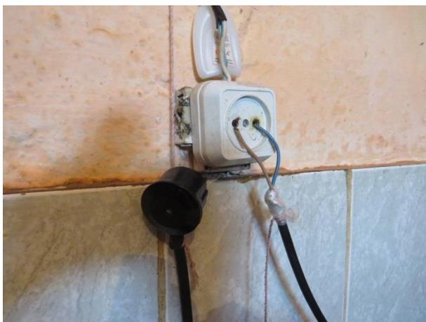
Фото. Оголённые электропровода в камере
