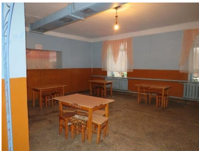
Покровское ССУ. Бетонные полы в столовой
