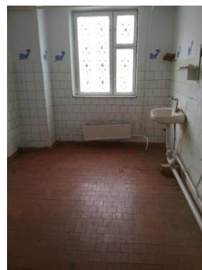
Токмокское ССУ №1. Санузел
