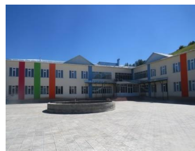
Новое здание ССУ
