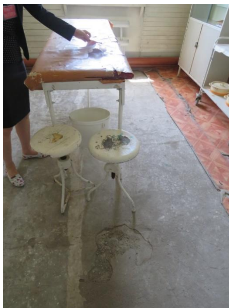
Фото 54. Процедурный кабинет медчасти в г.Ош
