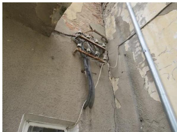
73 ДРПБ с.Ивановка, трещины и оголённые провода на здании больницы
