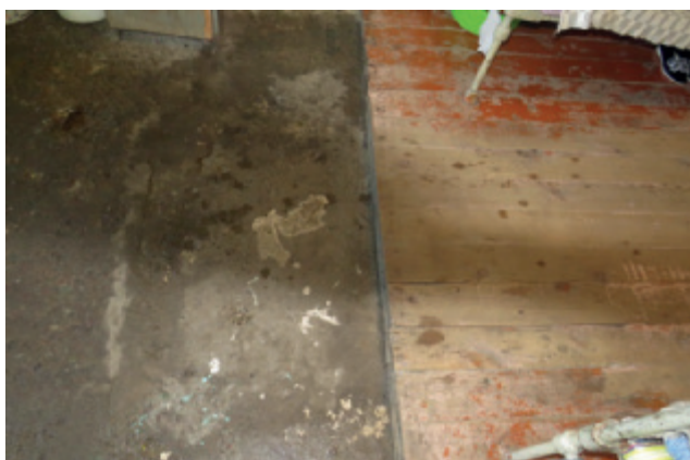
Фото. Бетонный пол с деревянным настилом в женской камере СИЗО ВК-14
