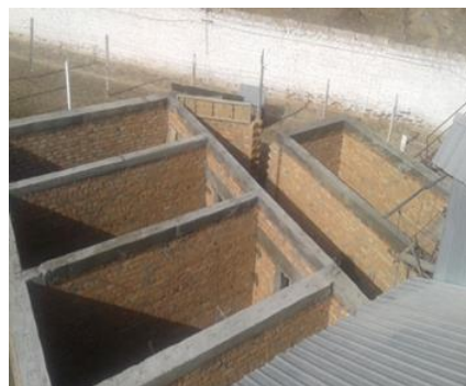
Фото 44. Прогулочный двор СИЗО-4 в ходе ремонтных работ
