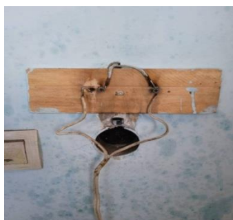
38-сүрөт. №10 мекеменин медбөлүгүндөгү ачык электр зымдары.
