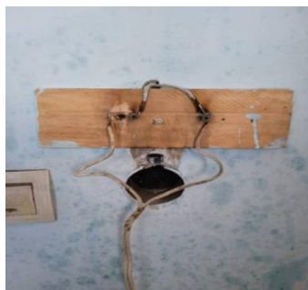
Фото 38. Оголенные электропровода в медчасти Учреждения №10
