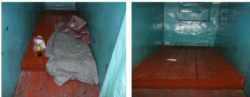
Фото 26, 27. Камеры для отбывания ареста УВД Свердловского района г.Бишкек
