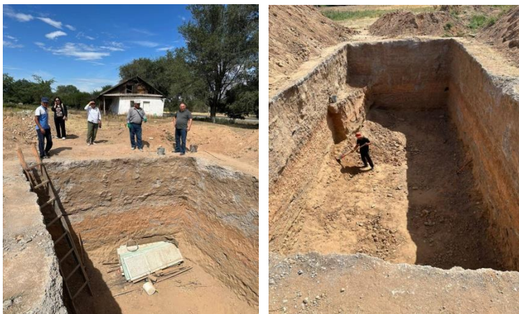
Фото 74, 75. Место строительства котлована на территории Токмокского ССУ по состоянию на август 2023 года
