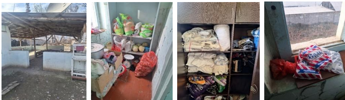
Фото №234,235. Состояние прогулочного двора и продуктового склада
